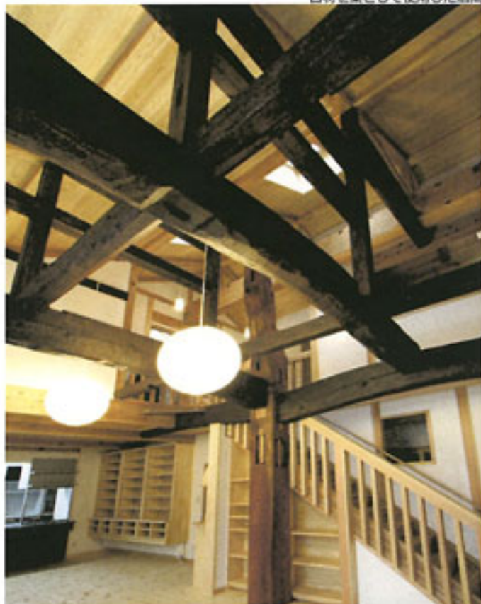
古材を梁として使用した居間
